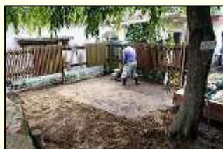
設置場所整地・転圧
