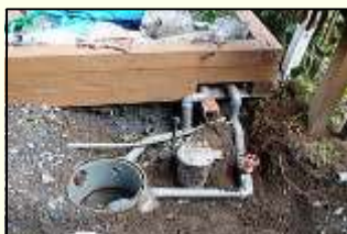
給水管・排水管接続
