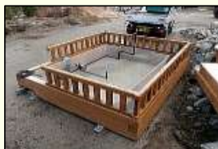
架台にFRP防水をした本体
