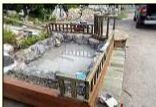
漏水テスト・アク抜き
